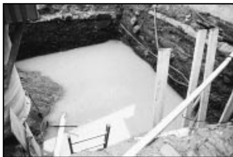
Utgravningsfeltet i Nedre Langgate i Tønsberg var ikke større enn 5 x 7 meter og 3,4 meter dypt.
